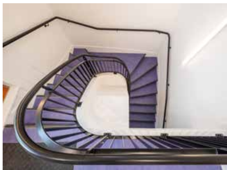
Nouvelle rampe de l'escalier
