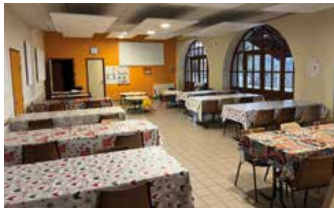
Pose de panneaux acoustiques
