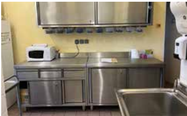
Installation d'un nouveau mobilier en inox pour la cuisine.
