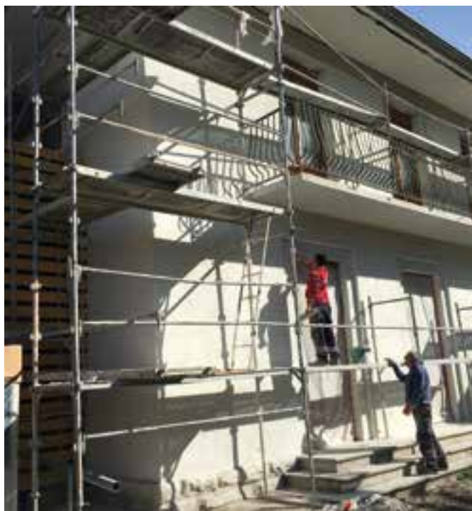
Préparation et peinture de la façade de l'ancien bâtiment
