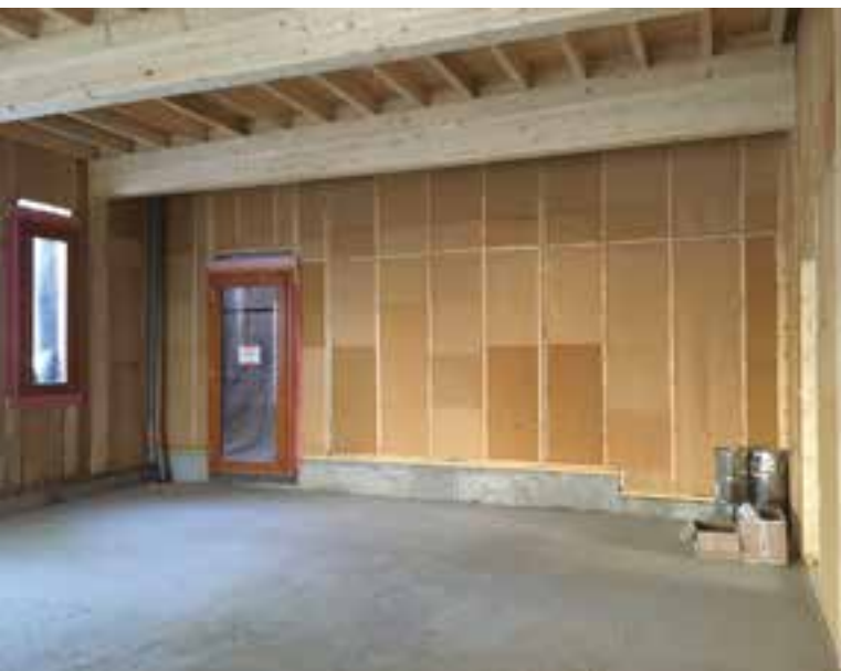
Isolation intérieure, étanchéité de l'extension et début de travaux sur la toiture.
