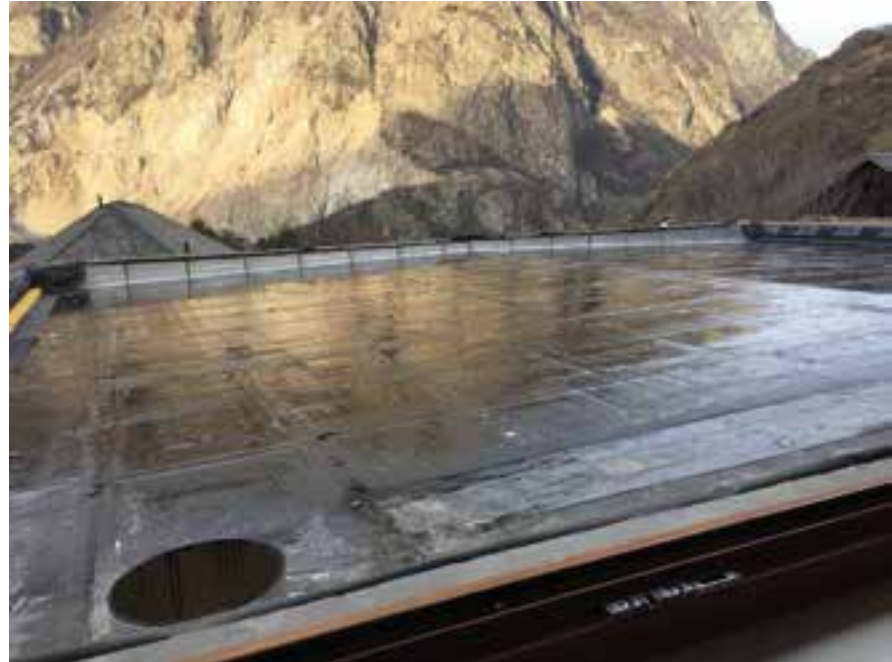
Etanchéité du toit plat de l'agrandissement
