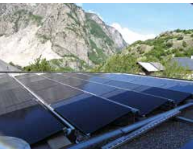
Pose des panneaux photovoltaïques
