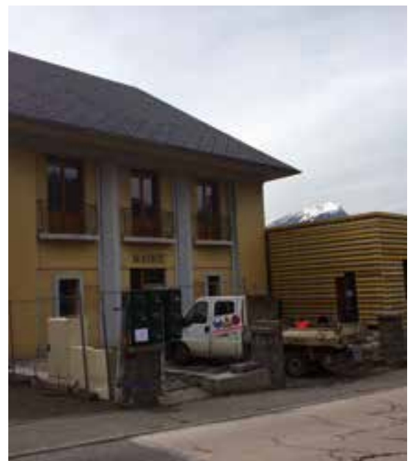
Travaux extérieurs (toit et agrandissement)
