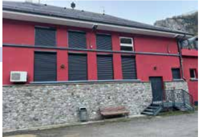
Les volets roulants ont été remplacés
