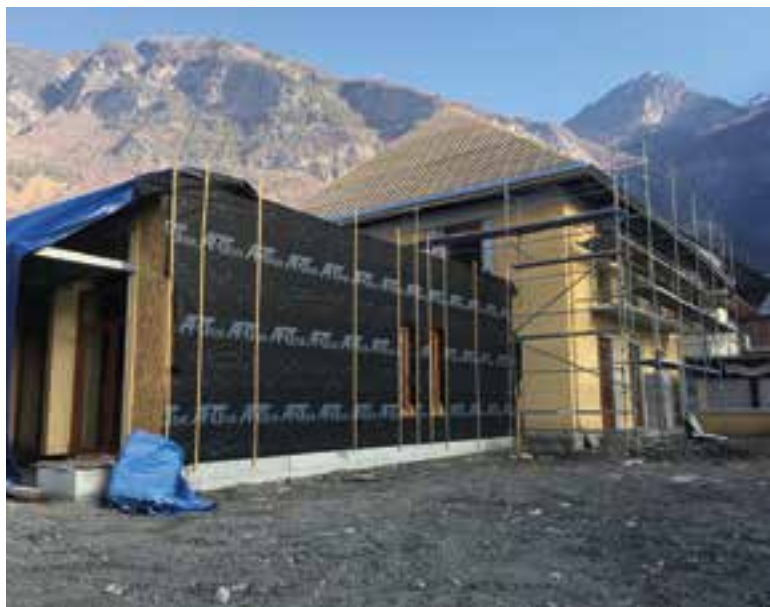
Isolation intérieure, étanchéité de l'extension et début de travaux sur la toiture.
