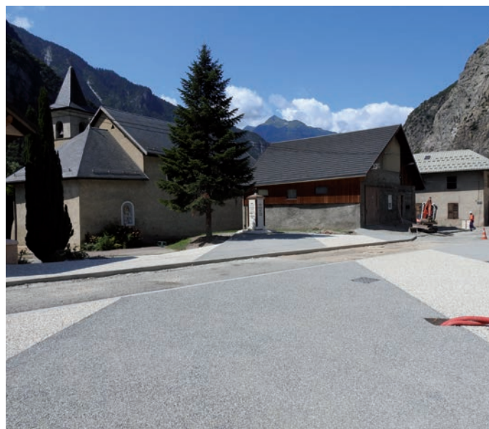
23 août 2021 : les places en béton désactivé sont terminées.
