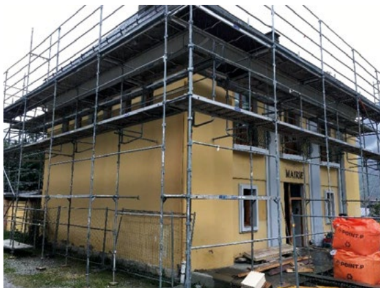
Installation des échafaudages
