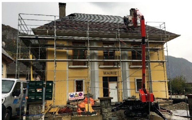
Reprise de la couverture de la toiture
