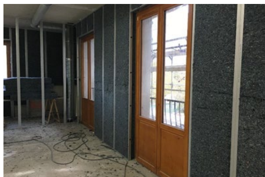
Isolation intérieure du bâtiment
