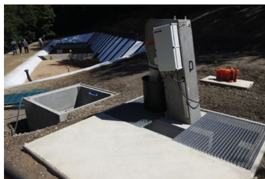
La partie technique : relevage et chambre de vannes
