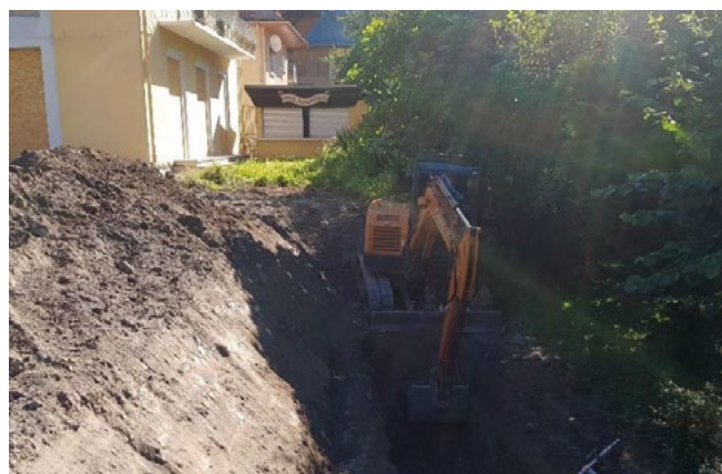
Début du terrassement et préparation fouille du mur de soutènement
