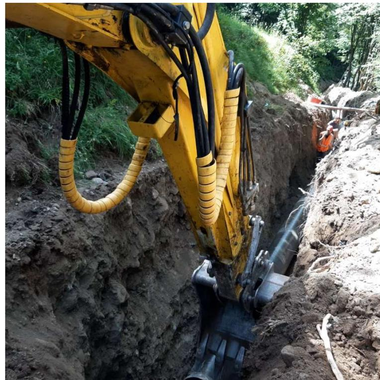
*Pose de la conduite forcée au front « intermédiaire »*
